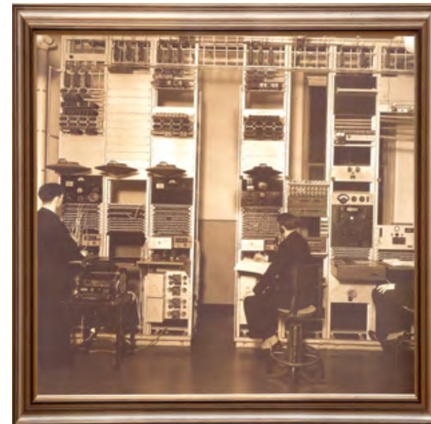
Salle de contrôle de radiodiffusion située dans le central interurbain (rue Belmont, Montréal), 1934
